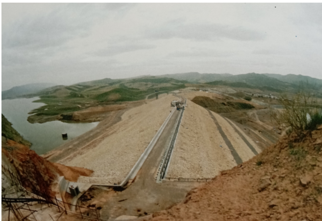
Рис. 2. Вид водохранилища «Достлук» и плотины со стороны Туркменистана
