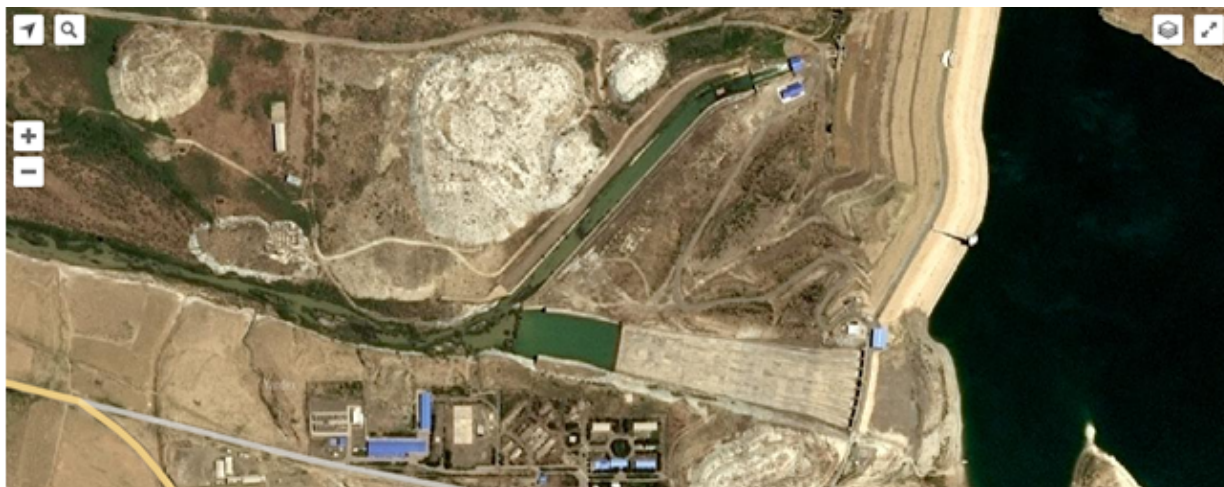
Рис.3. Вид водохранилища «Достлук», плотины и сооружений с космического снимка
